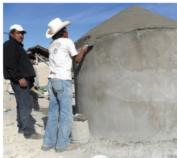
Construcción de una pila de agua, Sitagapachi.
